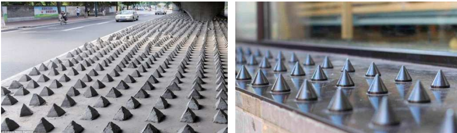
Figuras 2 e 3 – Spikes de concreto sob uma ponte e spikes de metal em uma soleira.
